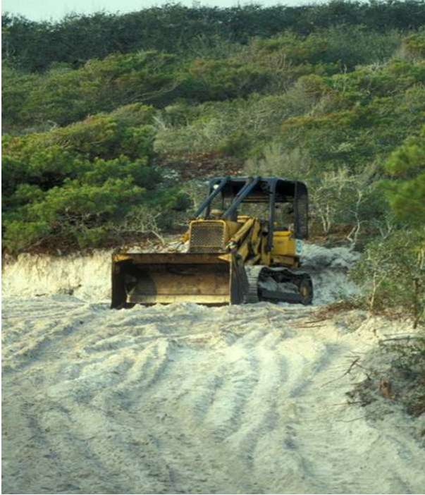
Figura 8. Utilización de vehículo pesado en Culebra, Puerto Rico.
