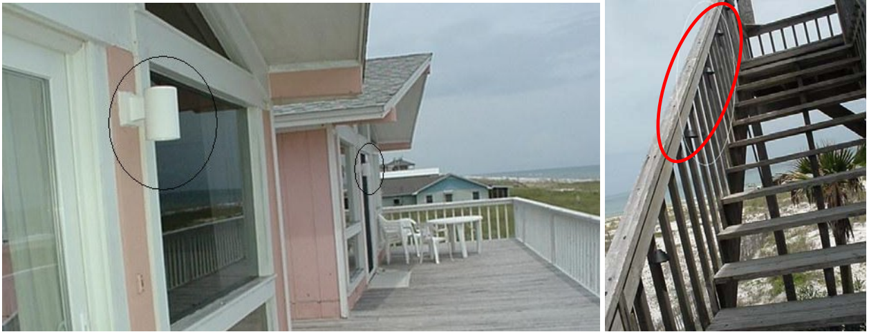
Figura 4. Ejemplos que muestran dos sistemas de iluminación diferentes donde se utilizan “turtle friendly lights”.
